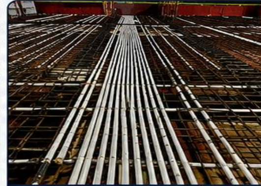
CONDUIT LAYOUT WORK
