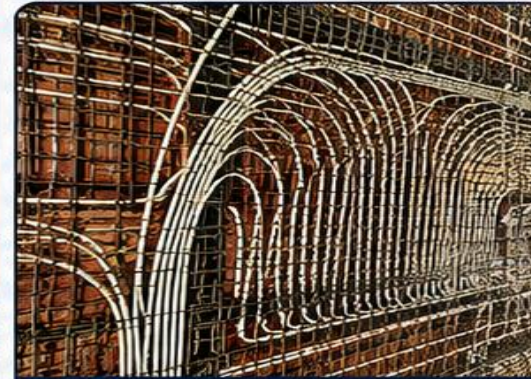
CONDUIT LAYOUT WORK
